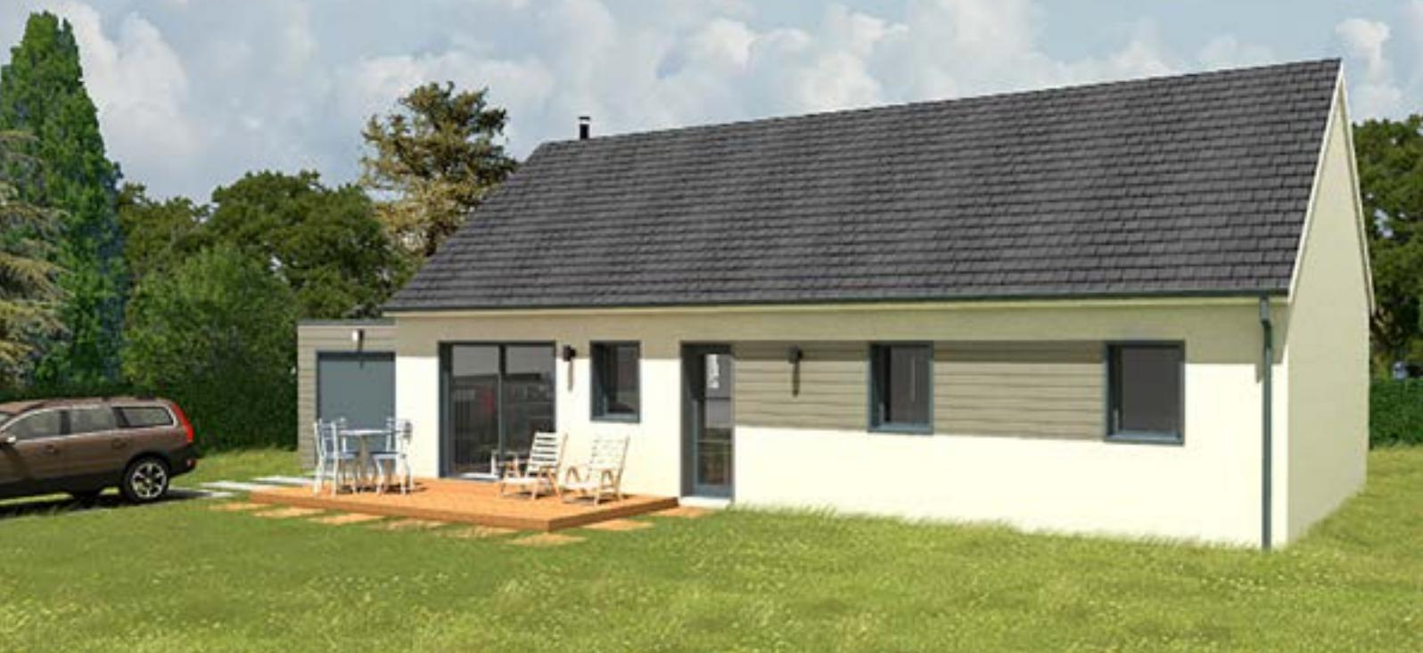
Construction AMB propose dans sa gamme Évidence, la maison Evi-You. Elle se compose d'une ossature bois et d'une charpente industrielle. Elle est revêtue d'un enduit monocouche et d'un bardage en Sapin du Nord.
