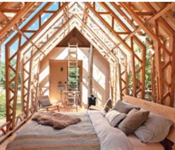
Le chalet Cabin Anna, livré en kit, est fixé sur des piliers en acier. Il possède deux coques différentes, en guise de murs extérieurs montés sur rails ! À l'aide d'une mini grue électrique, il peut être construit par trois personnes en cinq jours et démonté en trois jours.
