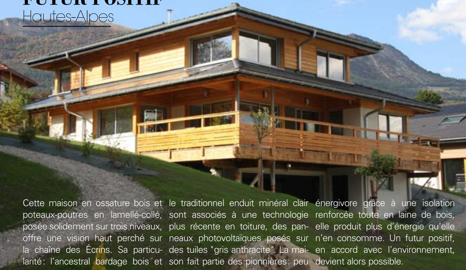
Cette maison en ossature bois et poteaux-poutres en lamellé-collé, posée solidement sur trois niveaux, offre une vision haut perché sur la chaîne des Écrins. Sa particularité : l'ancestral bardage bois et
