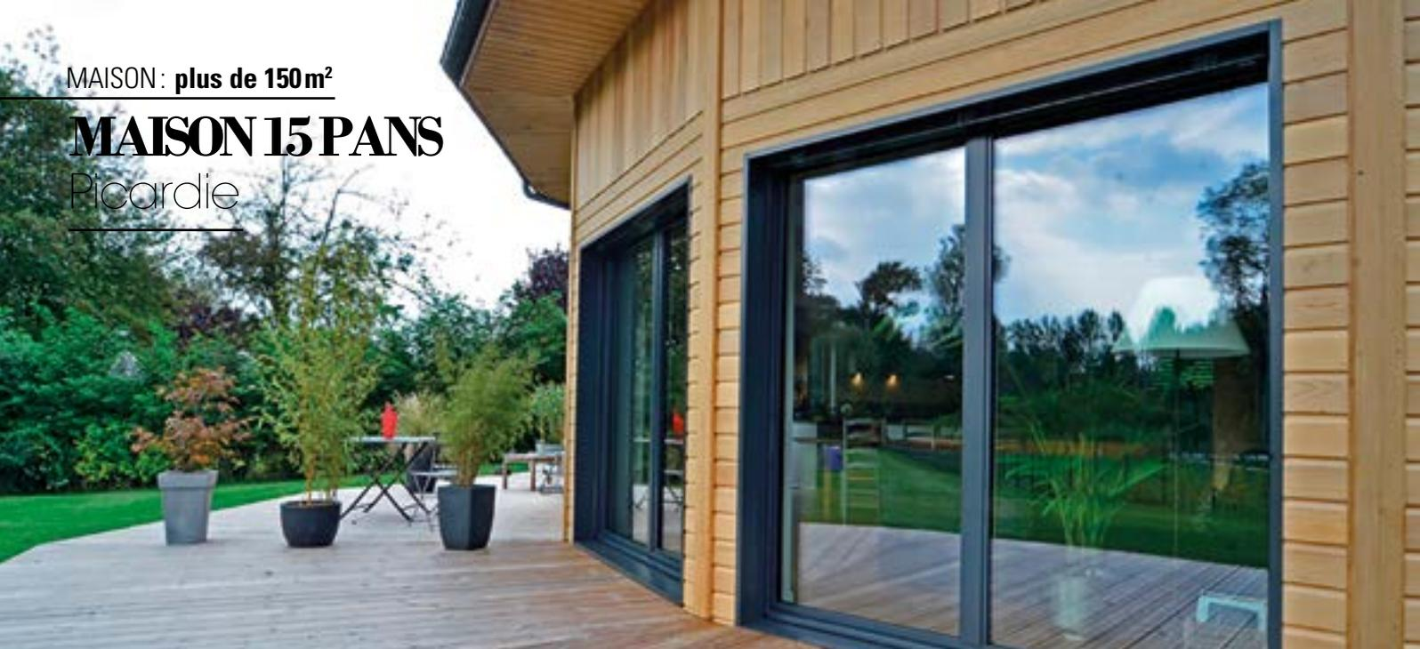
À 20 minutes d'Amiens, cette maison signée La Maison de Cèdre approche des standards de La Maison Passive. Construite en 15 pans avec des combles rehaussés et une aile habitable en plain-pied, elle bénéficie d'une orientation idéale et d'une isolation renforcée en ouate de cellulose. Ses menuiseries bois/aluminium sont en triple vitrage. Comme système de chauffage, les propriétaires ont opté pour un poêle à bois. Ils ne consomment que deux stères de bois par an.
