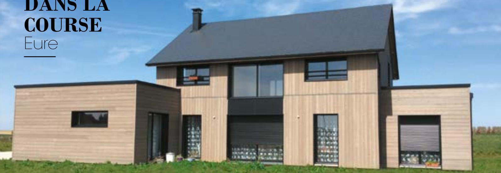
Quand les volumes sont imbriqués les uns dans les autres, quand les formes se confondent et que les hauteurs varient, l'architecture prend vie et devient unique en son genre. Celle-ci a été construite en ossature bois, sur un vide-sanitaire dans un axe Sud/Sud-Ouest. Le bois, en lames et panneaux, habillent les contours de cette maison de 183m<sup>2</sup>.
